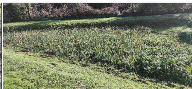
Bassin de rétention des eaux pluviales
